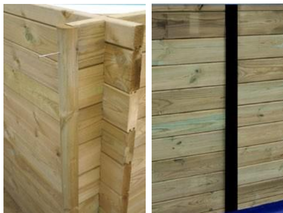
Figure 19 – Habillages en bois Figure 20 – Adhésif de protection
