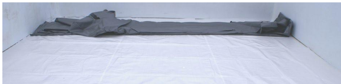
Figure 32 – Dépliage du liner
