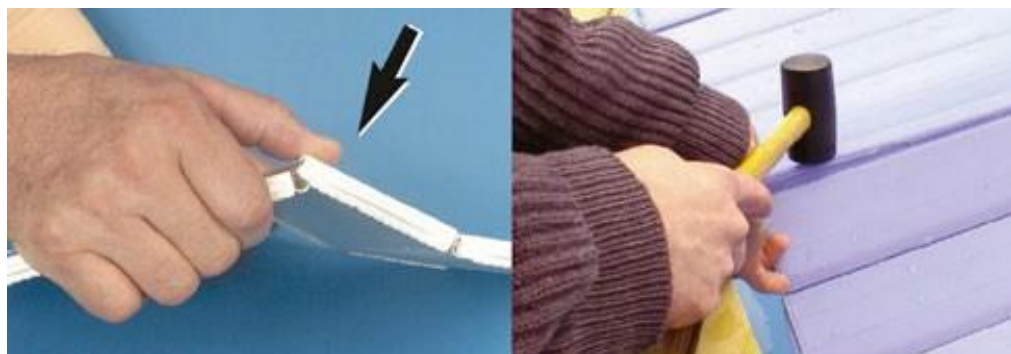
Figure 44 – Clipsage des lames
