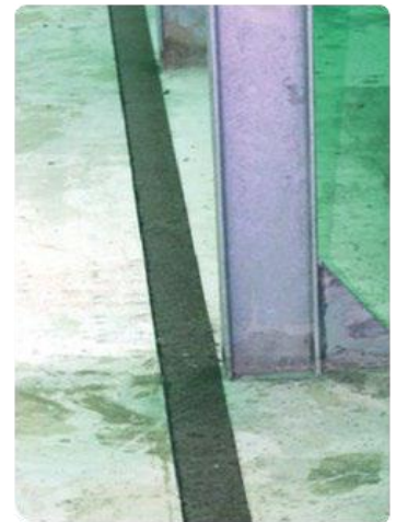
Figure 8 – Mise en place des bandes bitumeuses
