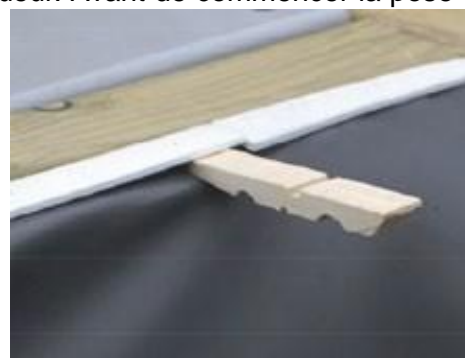
Figure 31 – Verrouillage du liner grâce à des demi épingles à linge
